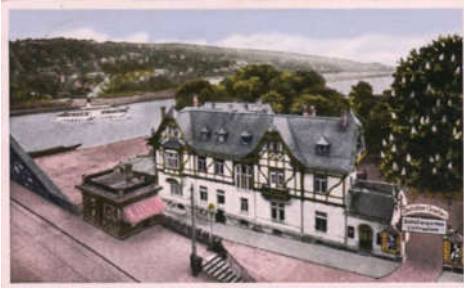
Abbildung 5: Eingang zum Kino im Restaurant Schillergarten, Postkarte 1939 (Quelle: https://altesdresden.de/pics/blas/schi009c.jpg ).
